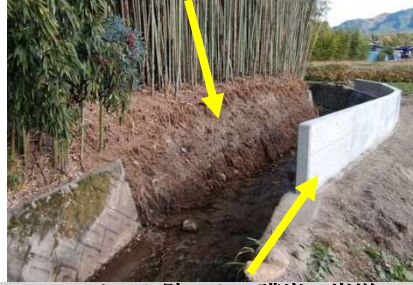
コンクリート壁による護岸の高増し
